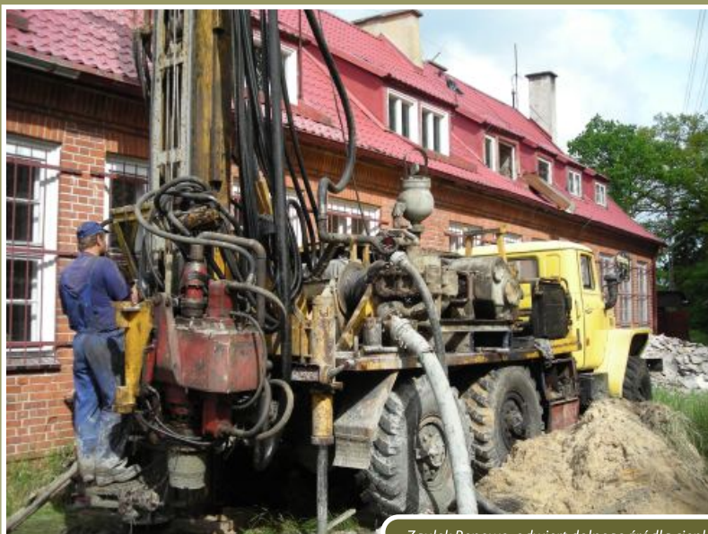
Zaulek Benowo, odwiert dolnego źródła ciepła oraz aparatura kontrolna pompy ciepła i kolektory źródło: Archiwum Stowarzyszenia Eko-Inicjatywa
